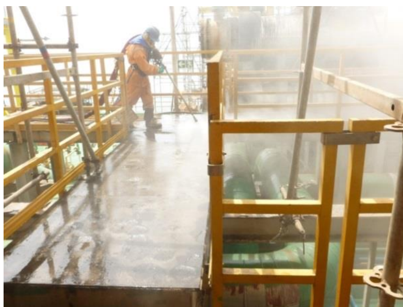
Figura 37 – Tratamento de superfície plana com hidrojateamento
