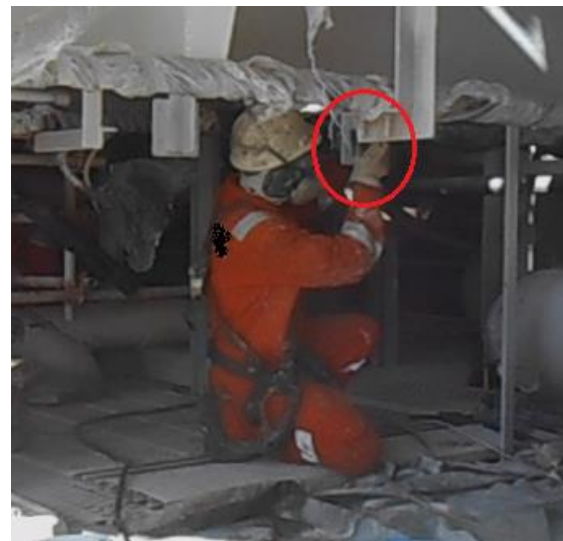
Figura 42 – Tratamento de superfície manual com o uso de lixas
