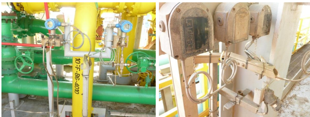
Figura 23 – Suportes de instrumentos e calhas de fios elétricos recompostos após a pintura
