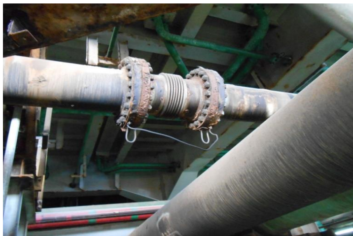
Figura 34 – Trecho de tubulação com necessidade de pintura
