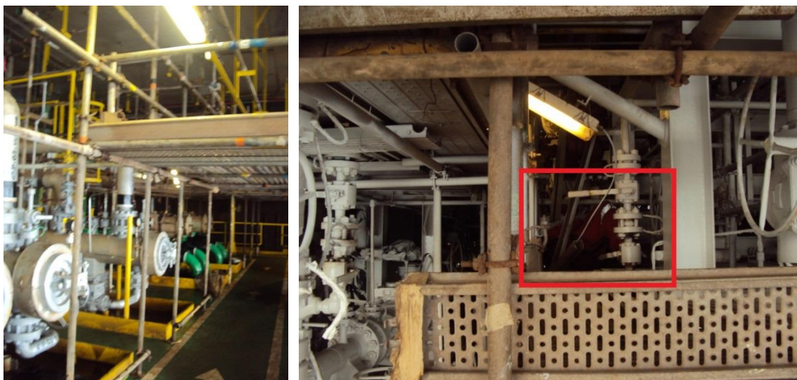
Figura 38 – Área com acesso restrito em virtude da proximidade de equipamentos e de andaimes montados (à esquerda) e pintor deitado em andaime para acesso a tubulações altas (à direita)
