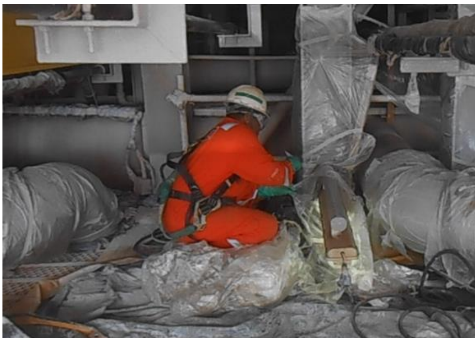
Figura 43 – Retirada de fitas e sacos plásticos utilizados no isolamento de tubulações e estruturas
