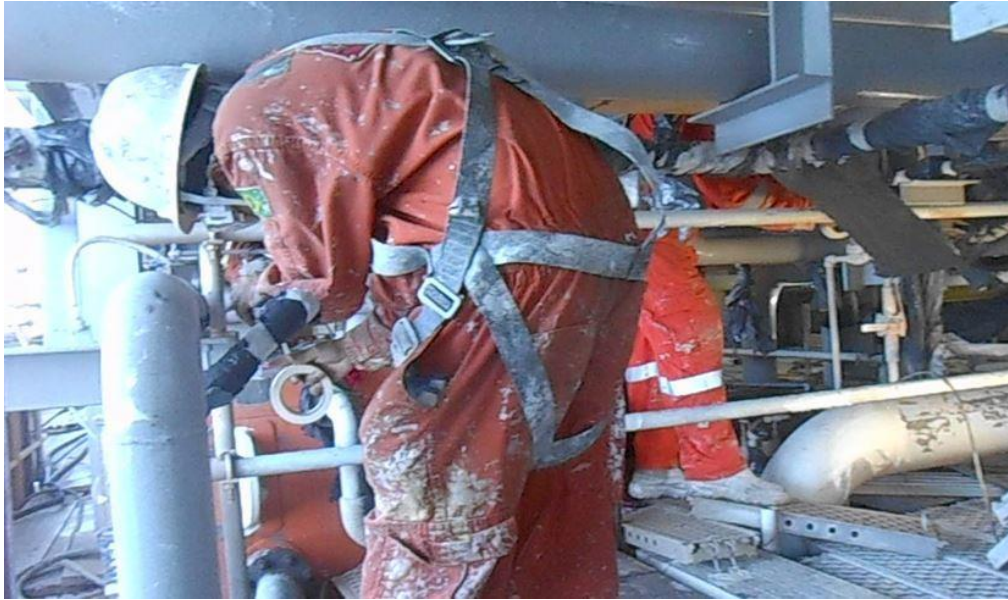
Figura 41 – Isolamento de tubulações e estruturas anterior à aplicação de tinta
