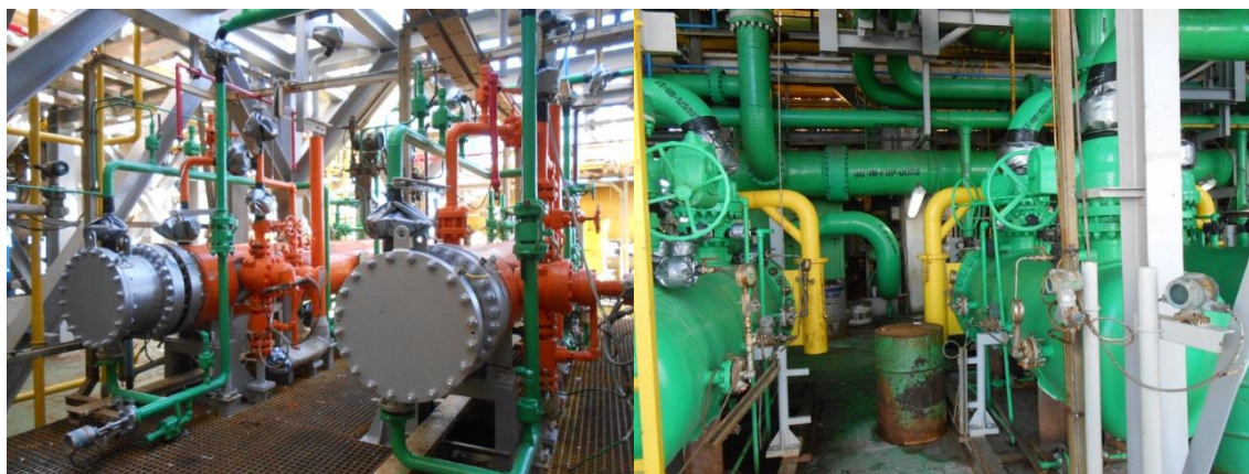
Figura 33 – A lógica do Setor de Pintura: a redução do percentual de corrosão a partir da pintura de áreas completas
