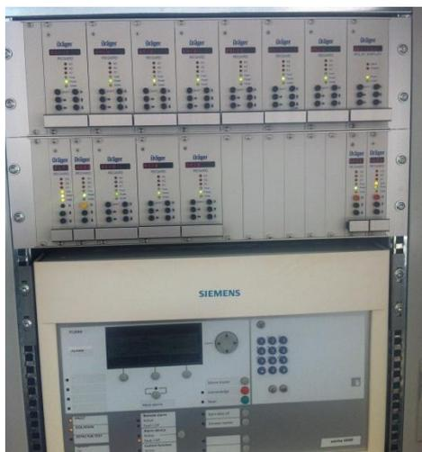
Figura 14 – Painel do sistema de detecção de fogo e gás.
