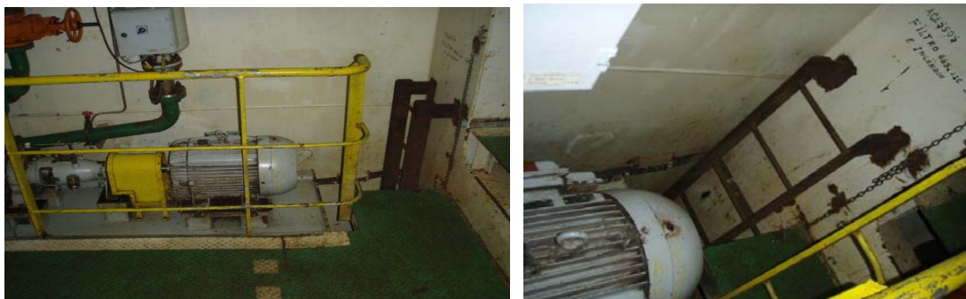
Figura 23: Escada de acesso
