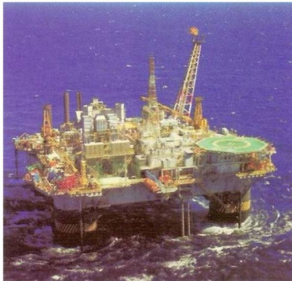
Figura 2 – Plataforma semi-submersível, Fonte: THOMAS, 2004
