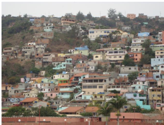
Figura 8 – Detalhe de ocupação desordenada das encostas Fonte:própria
