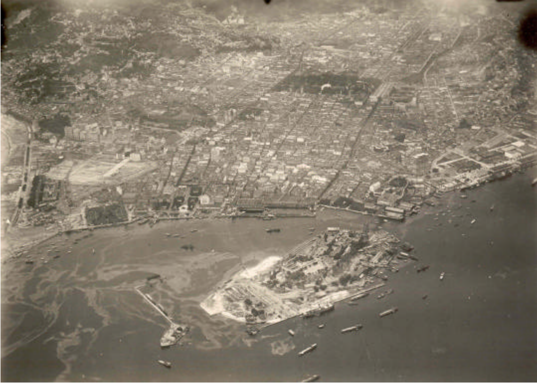
Figura 14 – O contorno da Ilha das Cobras e o molhe da Ilha Fiscal no início das obras – Fonte: SDM.
