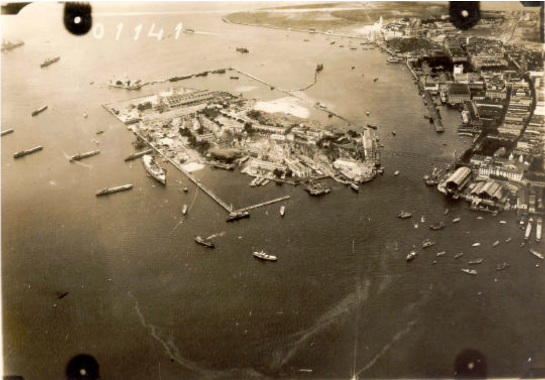
Figura 15 – Arranjo da Ilha das Cobras no início das obras de aterro do cais norte, em 04-01-1932 - Fonte: SDM.
