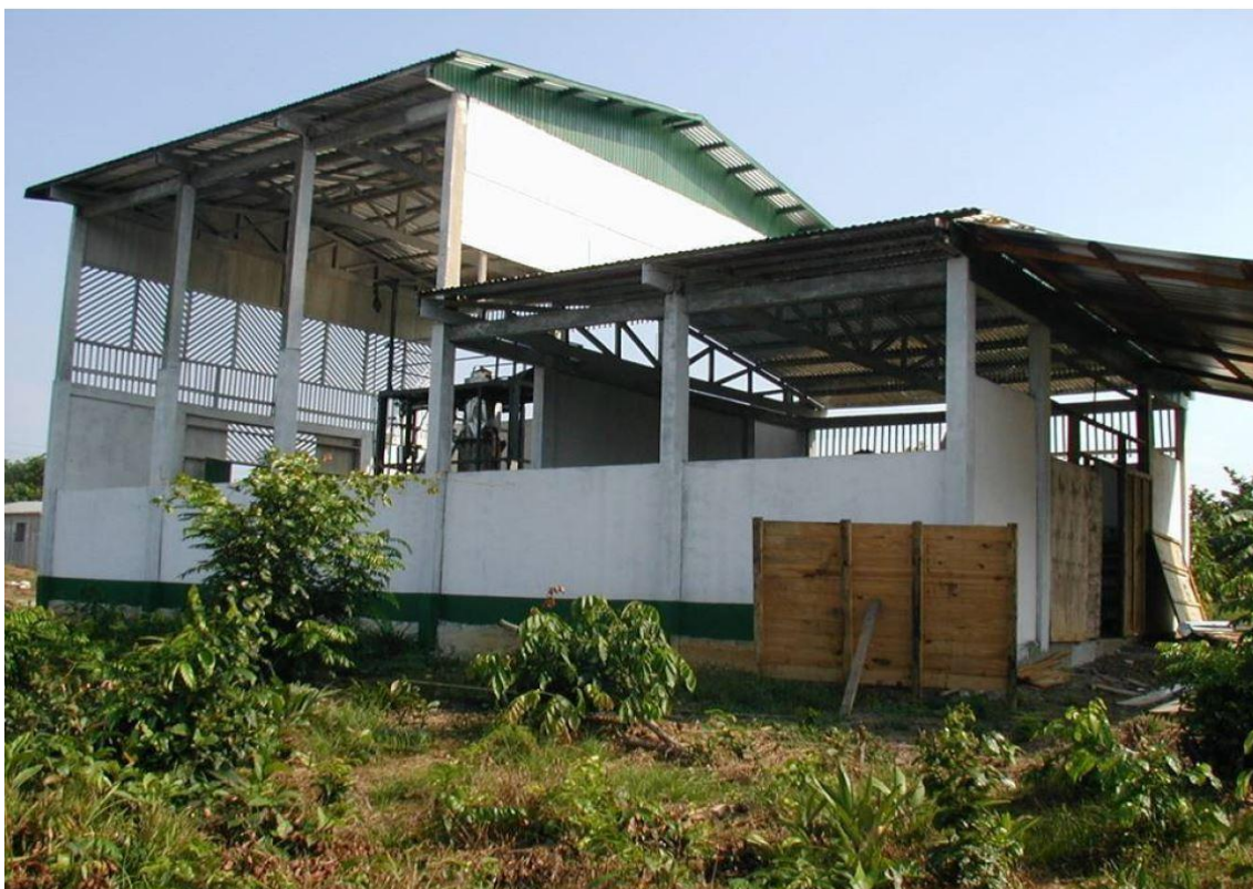
Figura 30 – Usina de gaseificação de biomassa no Brasil - Fonte CENBIO
