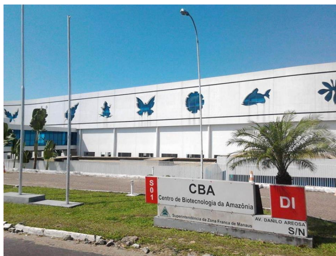
Figura 8 – Prédio do CBA
