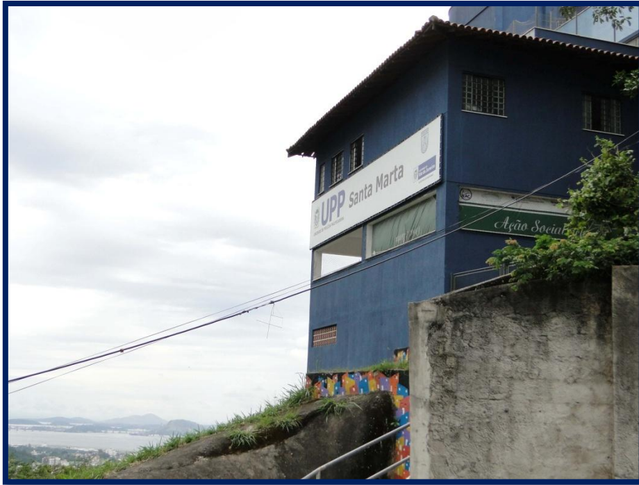
Figura 10. Parte do prédio onde fica a base da Unidade de Polícia Pacificadora na Santa Marta (foto tirada em 19/11/11, autoria própria).
