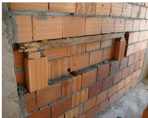
Figura 40 – Execução local do nicho na alvenaria
