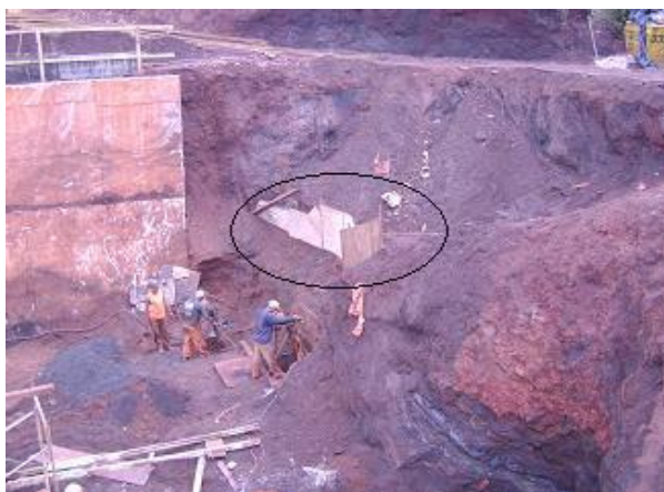
Figura 70– Barreira executada pelos trabalhadores
