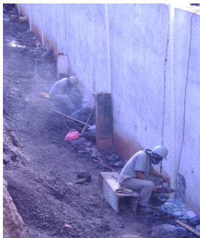
Figura 59 – Assentos improvisados para trabalhos com o martelete
