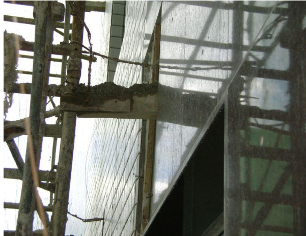
Figura 71 – Interferência para o assentamento do granito
