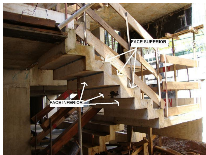
Figura 77 - Escada com degraus na face superior e inferior
