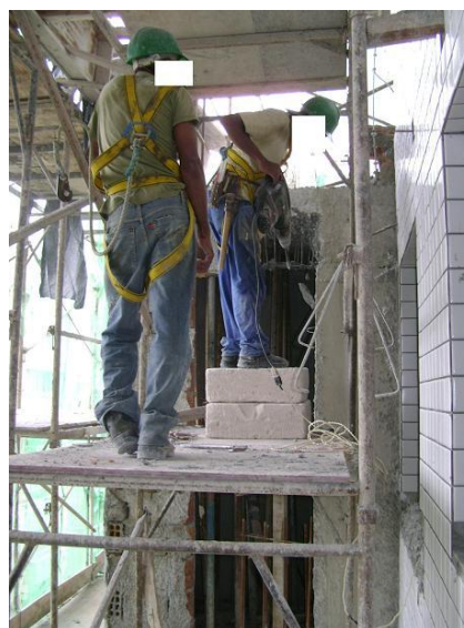
Figura 63 – Pedras sobre a plataforma do andaime
