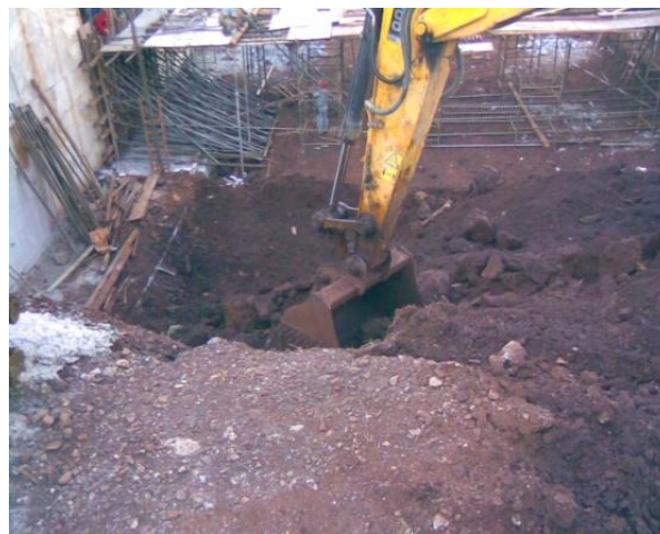
Figura 69 – Movimento de terra mecanizado
