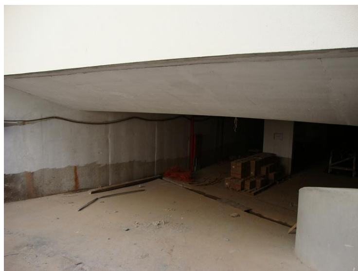
Figura 49 – Vista do ponto após execução
