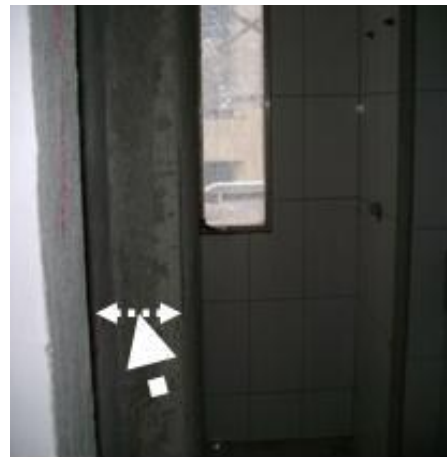
Figura 53 – Excesso a ser removido
