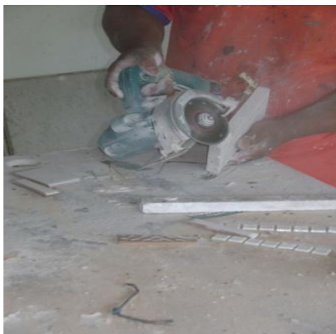
Figura 61 – Execução do chanfro no marco da porta
