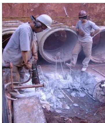
Figura 60 – Quebra de concreto das sapatas para execução das fundações
