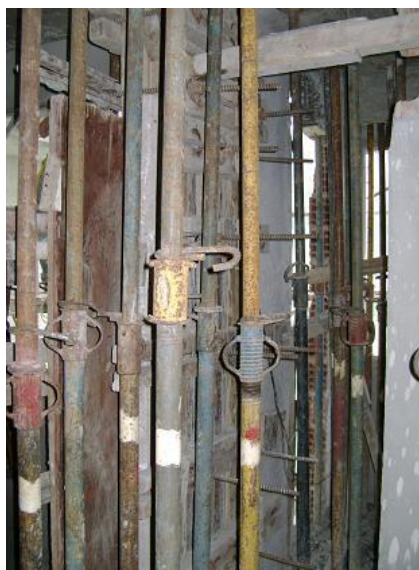
Figura 62 – Escoras dentro do WC
