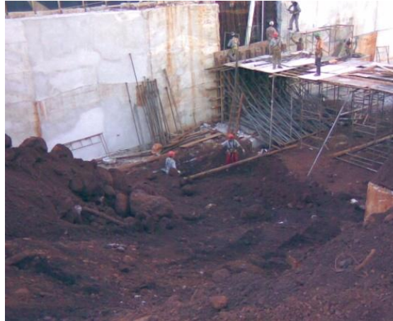
Figura 68 – Execução da fôrma do muro de contenção
