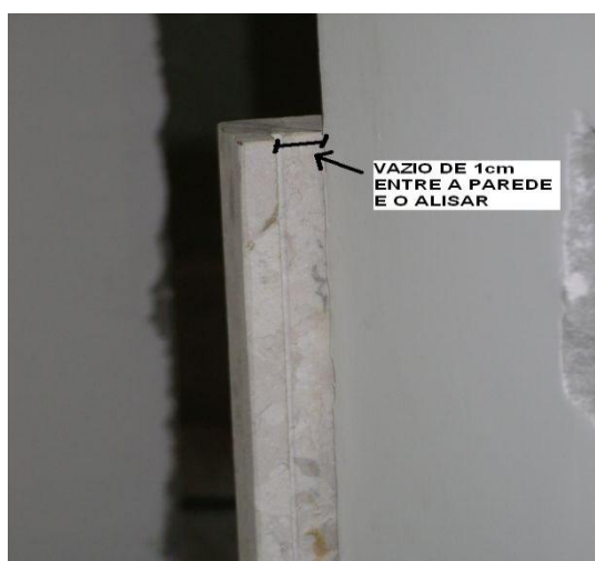
Figura 46 – Detalhe do vazio entre a parede e o alisar
