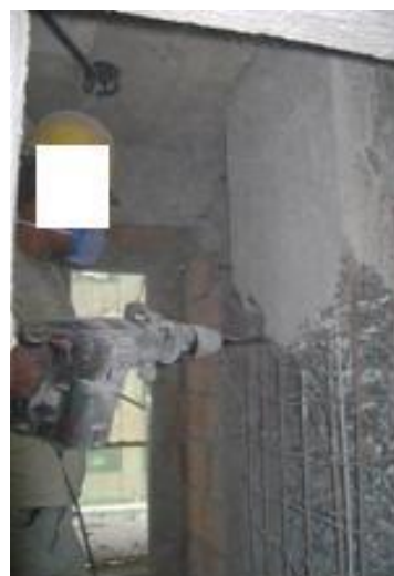
Figuras 64 e 65 – Retirada do excesso nos pilares do WC
