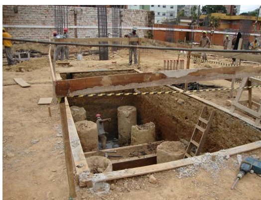
Figura 75 – Escavação de bloco sem plataforma com sarrilho
