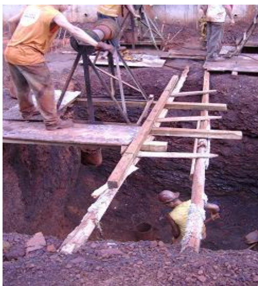
Figura 67 – Escavação de blocos: plataforma para instalação do sarilho
