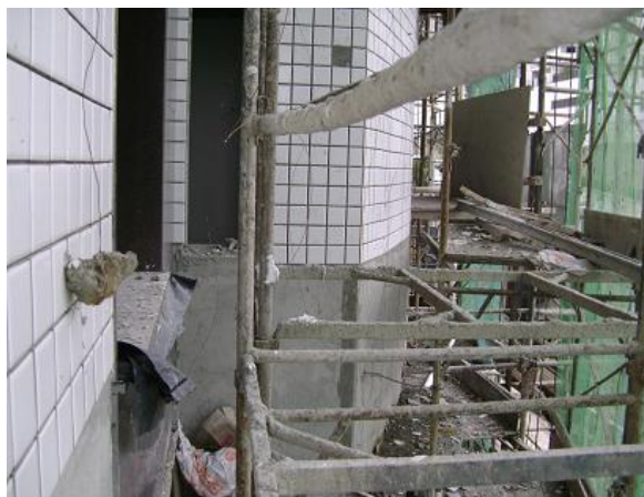
Figura 74— Sem interferência para o assentamento da cerâmica
