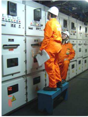
Figura 53 – Dificuldades para visualização das informações nos painéis elétricos
