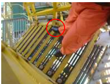
Figura 18 – Escadas com degraus estreitos
