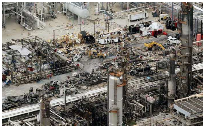
Figura 32 – Destroços após o acidente na BP Texas City Fonte: Relatório de Investigação do acidente BP Texas City
