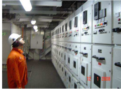
Figura 53 – Dificuldades para visualização das informações nos painéis elétricos
