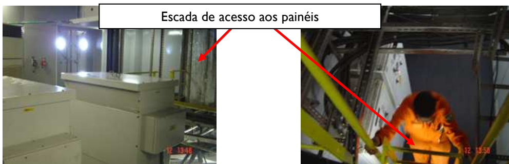
Figura 62 – Acesso ao mezanino
