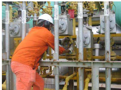
Figura 52 – Dificuldades para acesso aos volantes de válvulas
