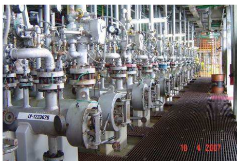
Figura 45 – Sistema de Lançamento e Recebimento de PIG
