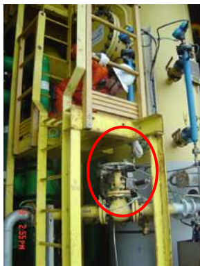
Figura 52 – Dificuldades para acesso aos volantes de válvulas
