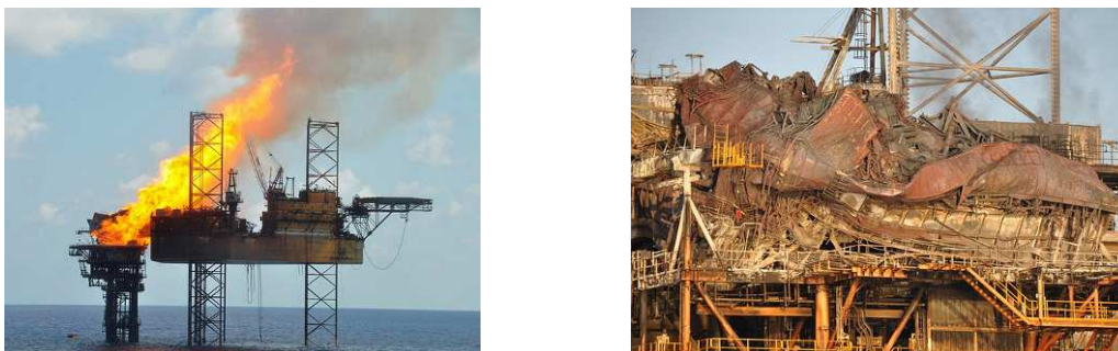
Figura 33 – Destroços da plataforma Atlas Oeste
