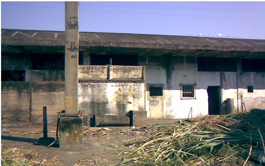
FIGURA 20b: GALPÃO CENTRAL DA RECICLA RIO
