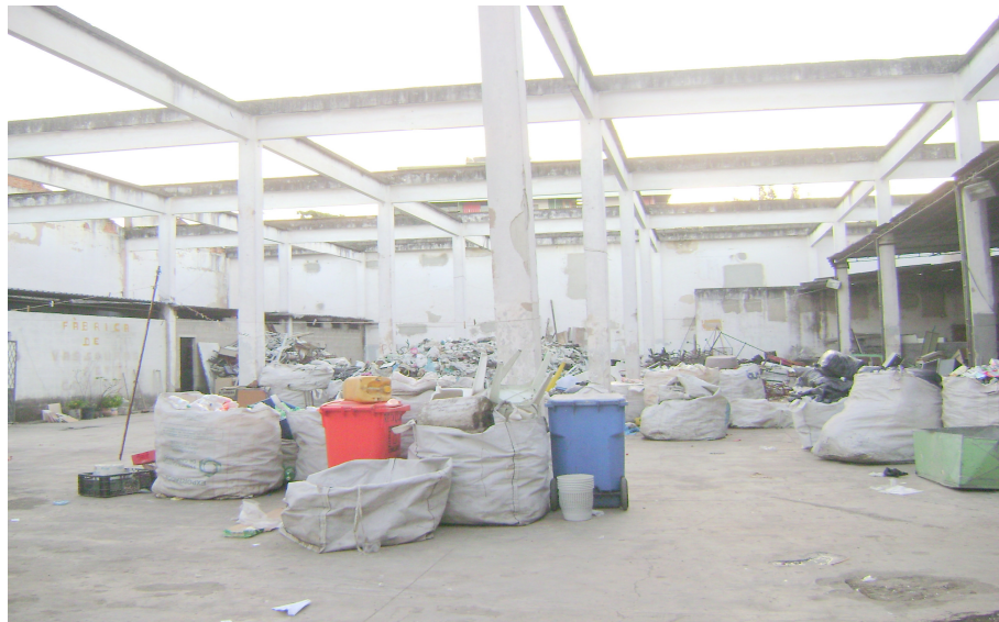
FIGURA 23: Galpão da COOPCAL
