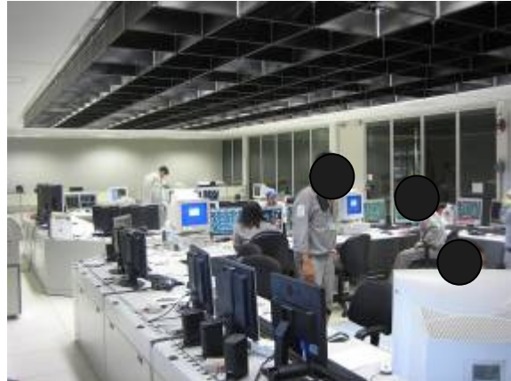
Figura 31: Consoles das equipes MOVGAS e MOVLIQ
