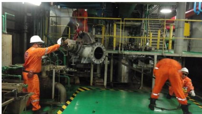
Figura 18 – Operadores puxam a bomba com o trefor para passar pelas interferências
