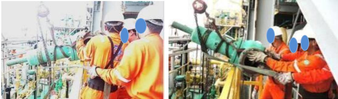
Figura 104 – Equipe tem dificuldade para passar com a PSV sobre o guarda-corpo
