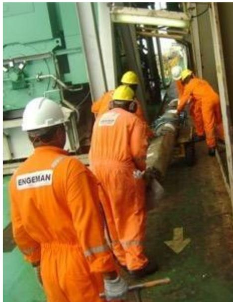
Figura 77 – Movimentação do medidor de vazão pela rota de fuga
