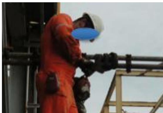
Figura 93 – Auxiliar desinstala a talha
