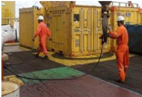
Figura 43 – Auxiliar conecta a extensão do moitão no guindaste
