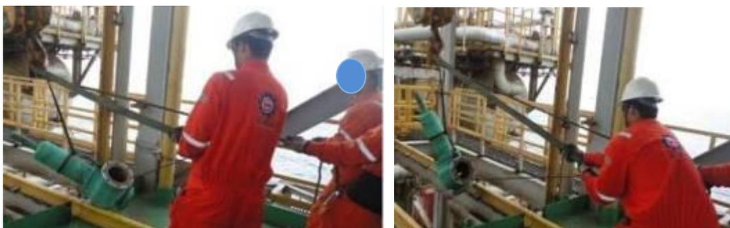
Figura 109 – Equipe segura a talha para evitar pancadas nas estruturas
