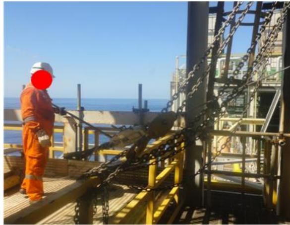
Figura 29 – Segundo *tirfor* utilizado na movimentação do *trolley* do permutador
