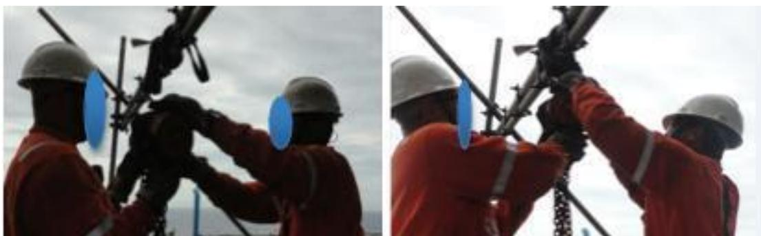
Figura 89 – Auxiliar e supervisor amarram talha na cinta
