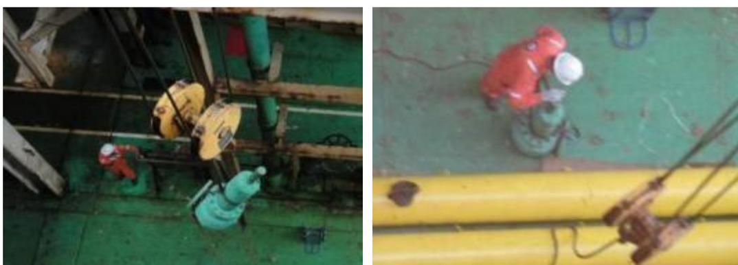
Figura 110 – Supervisor desce a PSV com a talha e auxiliar recebe no primeiro piso
