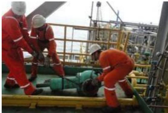
Figura 105 – Equipe estaciona a PSV e movimenta manualmente até a talha pneumática
