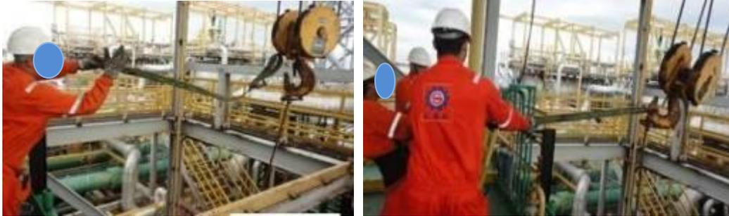
Figura 107 – Supervisor laça a talha e equipe a puxa o equipamento para o piso
