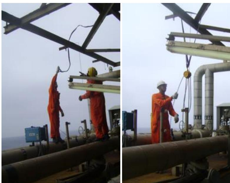
Figura 78 – Montagem da talha
