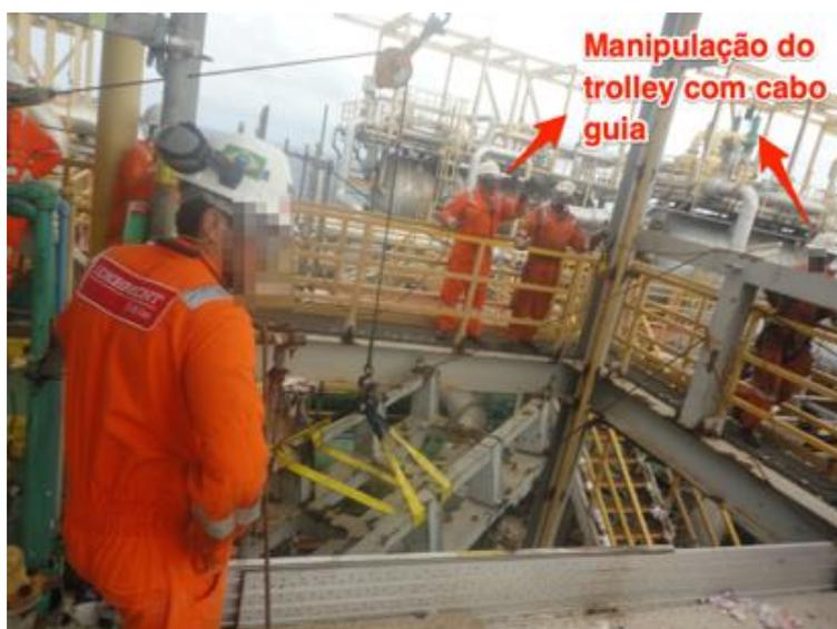
Figura 27 – Manipulação do *trolley* com cabo guia
