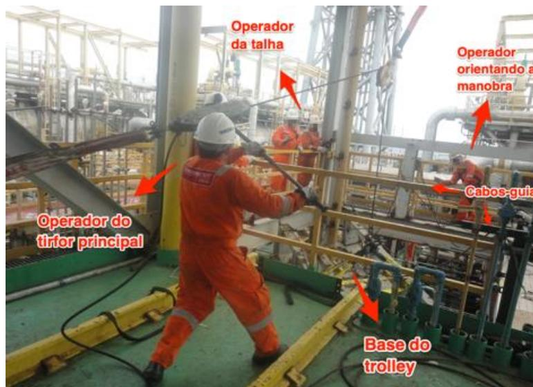
Figura 26 – Descida da base do *trolley* do permutador do topo do Módulo 2B
