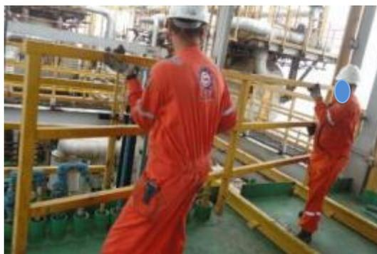
Figura 106 – Auxiliar e supervisor retiram portão para acessar a talha pneumática
