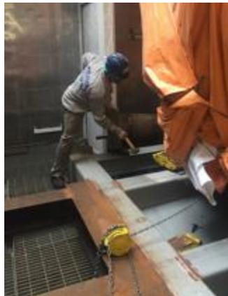
Figura 42 – Remoção dos *skates* com martelo após o gerador chegar próximo ao berço
