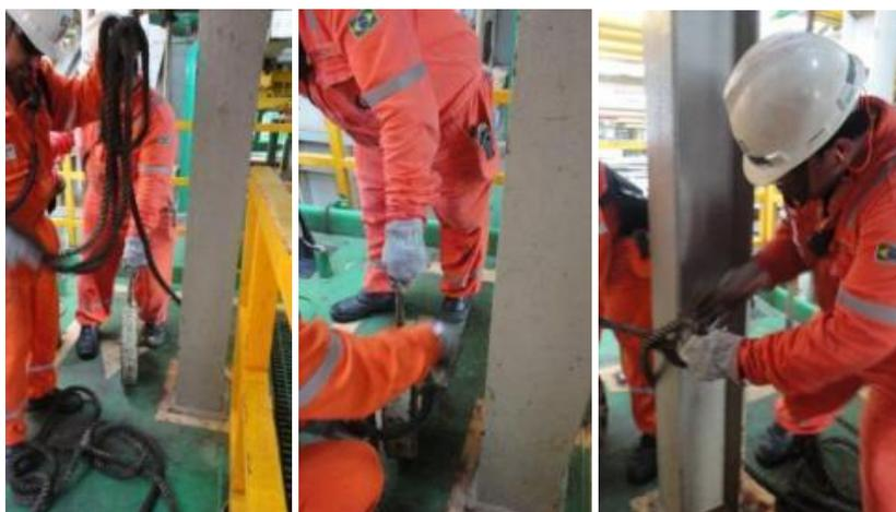
Figura 7 - Auxiliar e supervisor recebem o cabo, amarram no flange e enroscam no pilar
