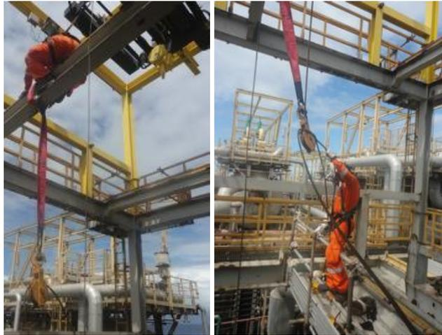
Figura 23 – Montagem das roldanas e passagem dos cabos dos *tirfores*
