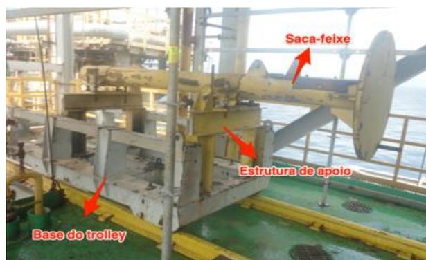
Figura 22 – Trolley do permutador
