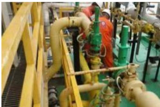
Figura 99 – Operadores movimentaram PSV manualmente até o 2º ponto de elevação
