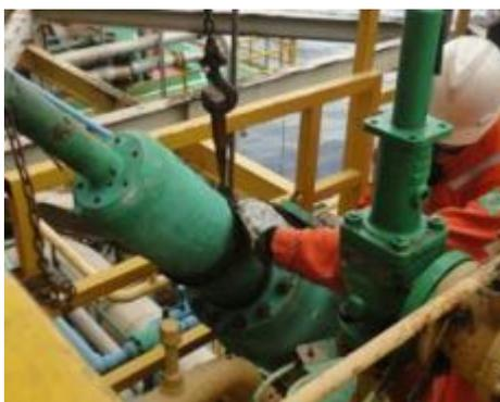
Figura 102 – Supervisor desvia PSV para não agarrar novamente na tubulação
