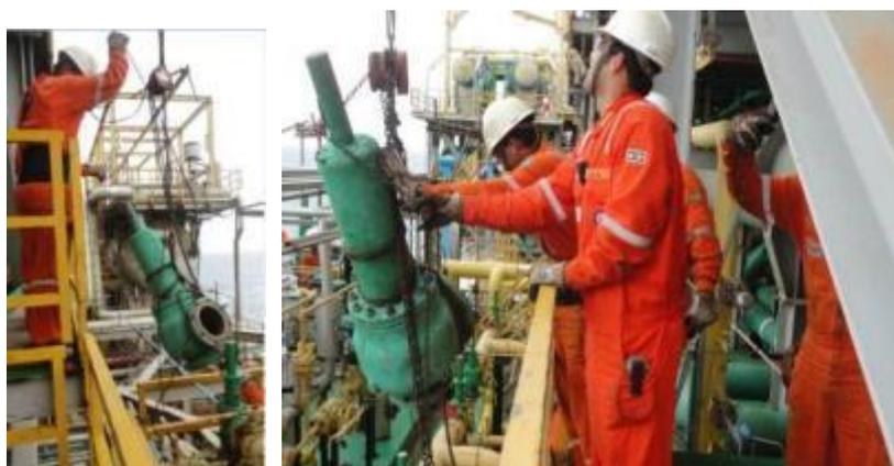
Figura 103 – Auxiliar finaliza elevação da PSV
