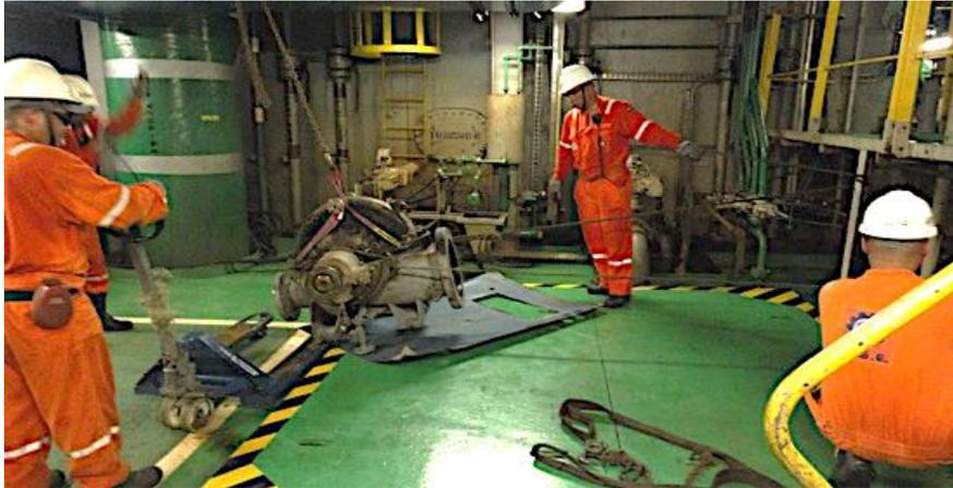
Figura 20 – Operadores montam sistema com talhas e cabos para alocar bomba na paleteira
