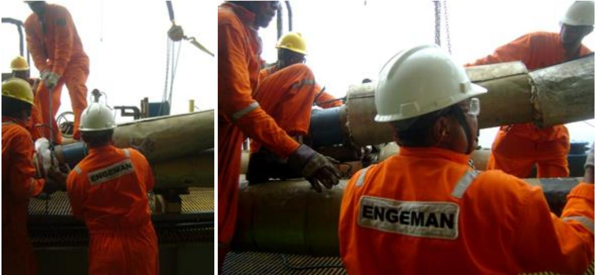
Figura 81 – Operadores empurram o medidor por cima dos equipamentos instalados
