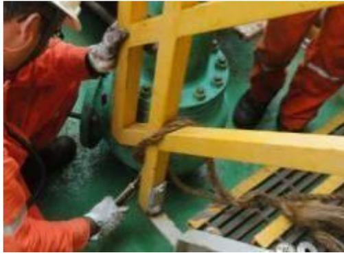
Figura 92 – PSV não passa pelo espaço entre o guarda-corpo e um andaime montado
