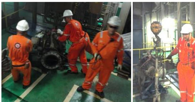
Figura 21 – Movimentação da bomba com paleteira e, em seguida, elevação com talha pela gaiúta
