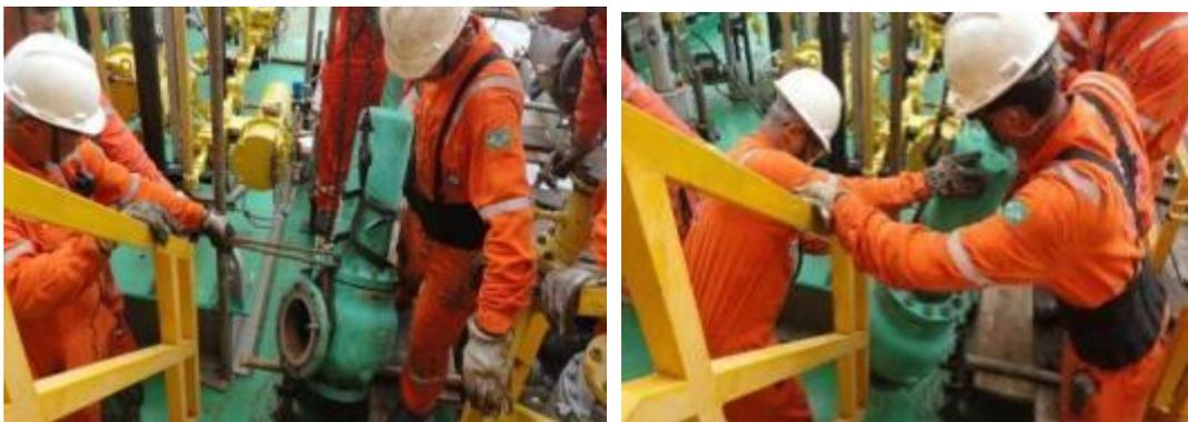
Figura 98 – Operadores passam a PSV por cima do andaime com o auxílio de cabo-guia
