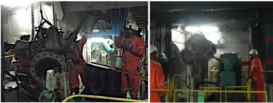
Figura 17 – Elevação, remoção da bomba do berço e alinhamento à monovia
