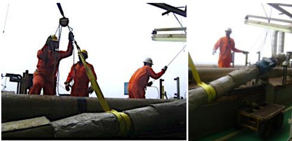
Figura 80 – Problema de coordenação leva a instabilidade da carga e revisão do plano
