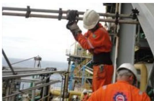
Figura 88 – Auxiliar sobe no guarda corpo e prende cinta no andaime
