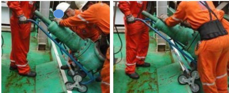
Figura 112 – Equipe utiliza carrinho de três rodas para passar por degrau
