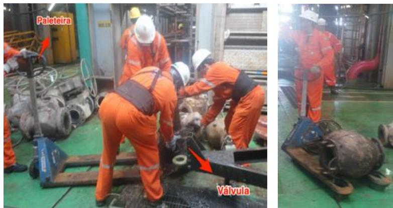
Figura 24 – Retirada das válvulas do piso do corredor vertical
