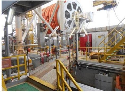
Figura 75 – Conexão entre planta de processos e castelo de proa feita com andaimes
