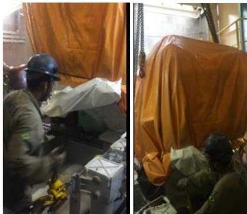
Figura 41 – Uso de *tirfores* para trazer o motor do gerador para a área próxima ao berço
