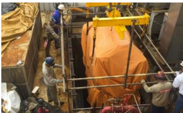
Figura 34 – Movimentação do novo motor do gerador pela saída de ar
