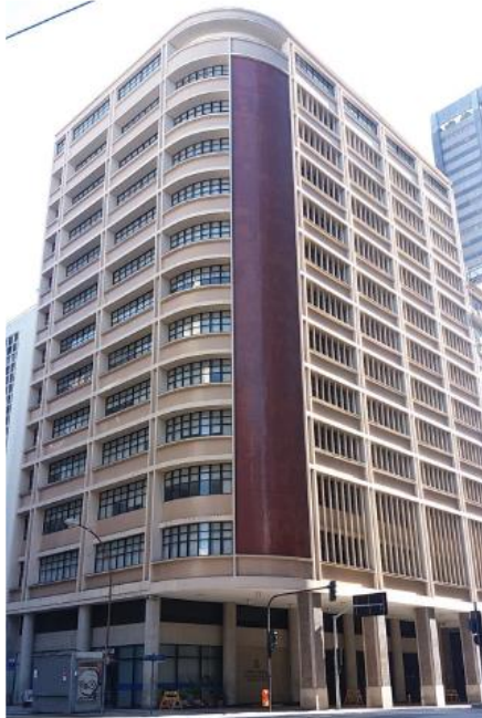
Figura 3.10: Ed. Sede da Justiça Federal Fonte: Própria
