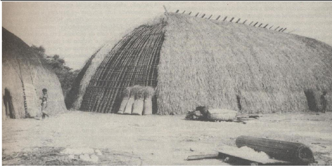
Figura 1.3: Oca em construção dos índios Kamayurá, Parque Nacional do Xingu Fonte: COSTA e MALHANO, 1983, p.53
