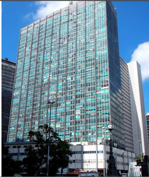
Figura 1.4: Ed. Avenida Central (RJ)
