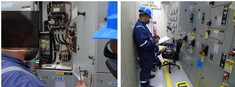
Figura 31 : Inspeção no PCM 01
