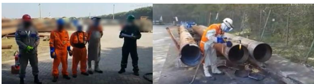
Figura 40: Atividade de Oxicorte em tubulações
