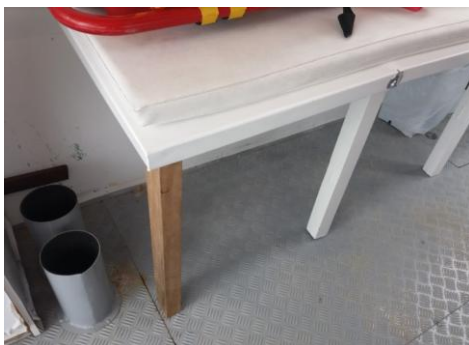
FOTO 32: Maca executada sem a estrutura necessária, com sarrafo de madeira como paliativo
