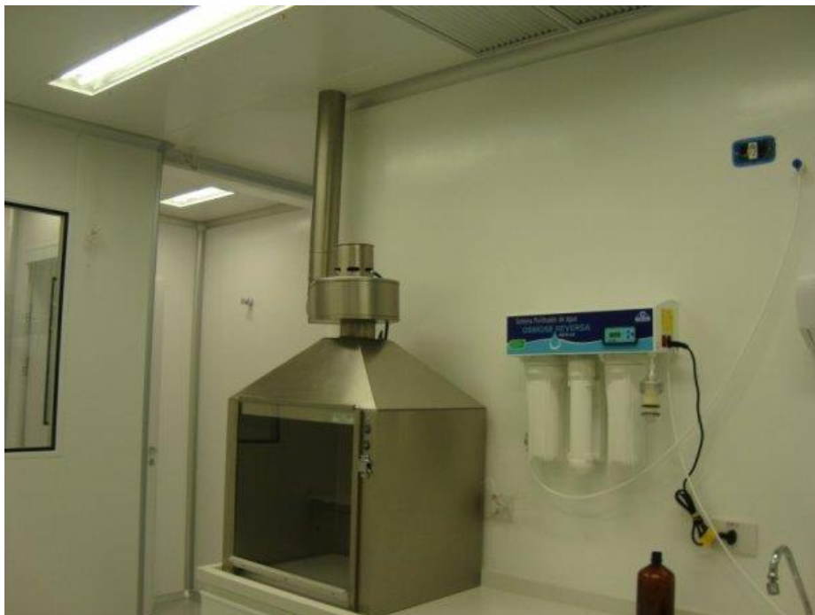
Figura 37: Exemplo de instalação de exaustores em laboratórios.
