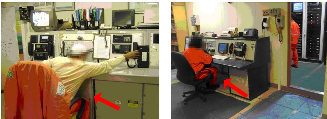
Figura 34 – Exemplos de diferentes padrões de bancadas: a primeira não apresenta espaço para as pernas do operador, dificultando seu acesso aos equipamentos, a segunda, possui espaço para as pernas, permitindo ao operador permanecer com uma postura mais adequada
