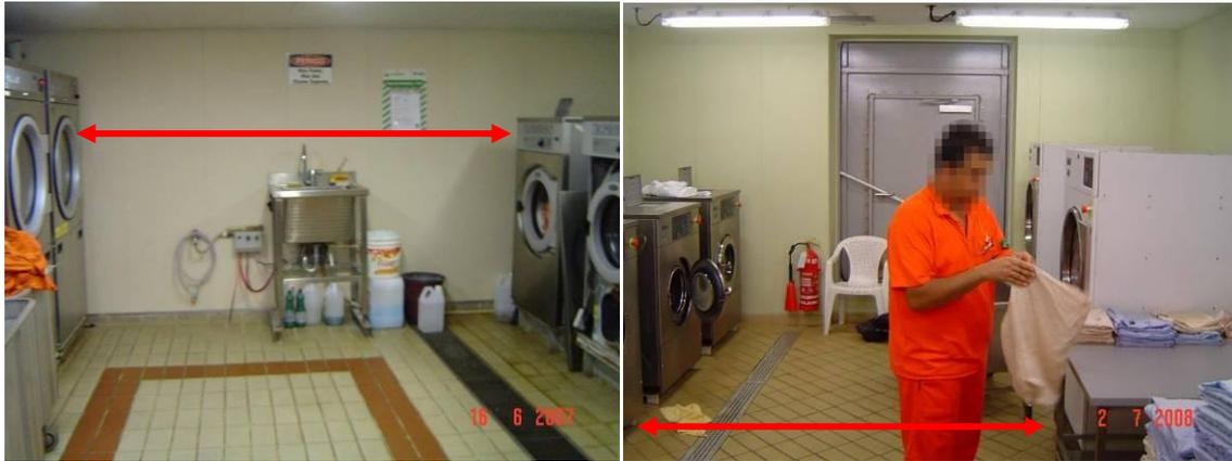
Figura 33 – Exemplos de espaço necessário para circulação (inclusive com carrinhos) na frente dos equipamentos
