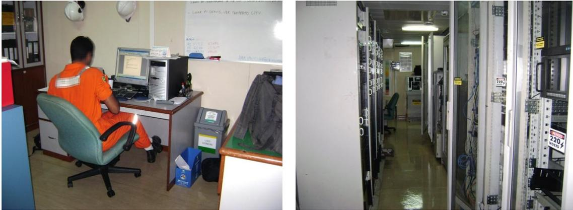
Figura 19 – Sala de telecomunicações: ambiente único para o posto de trabalho do técnico e para os *racks* de equipamentos
